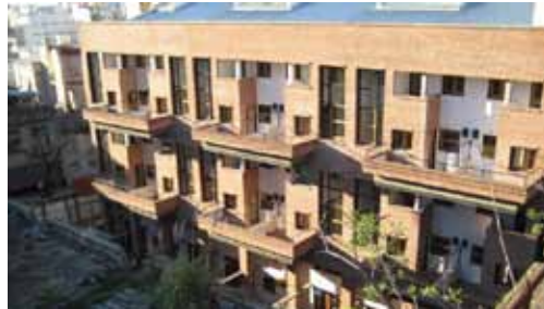
Imagen 4: Obra finalizada de la Cooperativa El Molino – MOI Solís 1967 (Constitución). 21 Viviendas.
