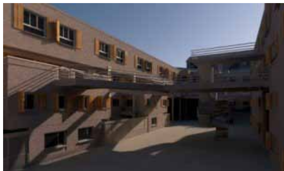
Imagen 9: Proyección de obra de la Cooperativa La Fábrica – MOI Icalma 2001 (Baracas). 49 Viviendas.
