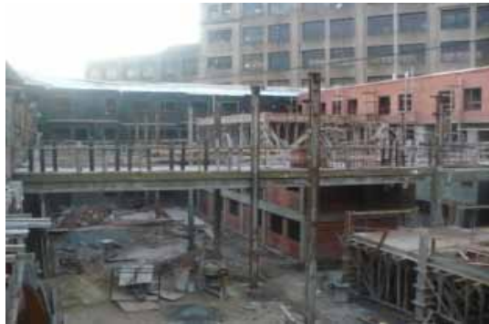
Imagen 8: Obra en construcción de la Cooperativa La Fábrica –MOI Icalma 2001 (Constitución). 49 Viviendas.
